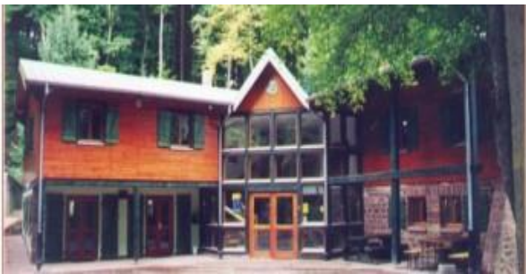
Au Chalet du CV à Lembach (67)
